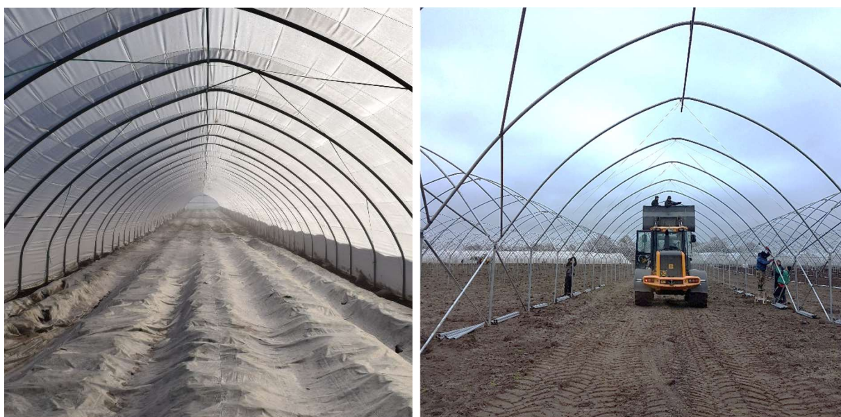
Till vänster: Tunnel för tidig produktion av jordgubbar, med enskilda bågar och med fiberduksdrivning. Till höger: Uppbyggnad av tunneltyp med gemensamma ben.
